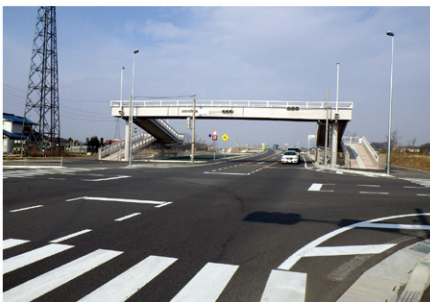
上武道路函渠他 (群馬県前橋市)
