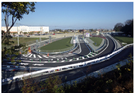
関越上里スマートIC (埼玉県本庄市)
