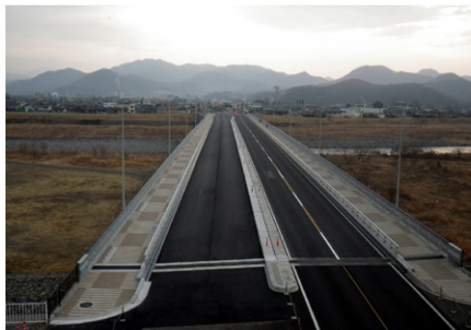
中通り大橋上部工床板 (群馬県桐生市)
