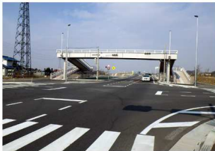
上武道路函渠他(群馬県前橋市)
